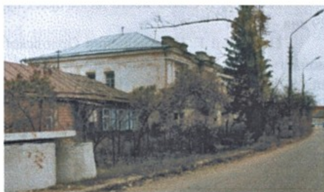
Здание бывшей консистории. Современный вид (ул. Ермолова, 11)
